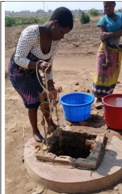
Installatie bij familie Sikadzakokha.+265993875893 Deze familie had een open hand gegraven put van 1 meter diep die droog gevallen was.
