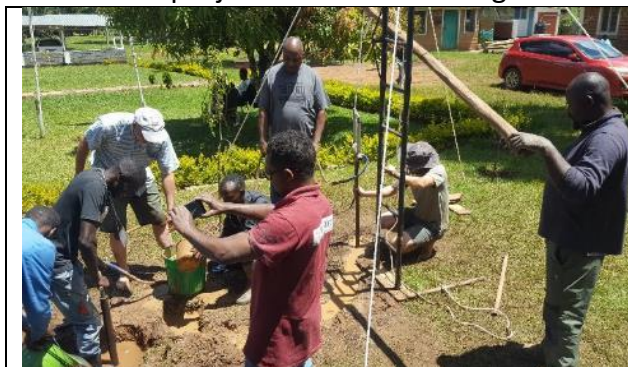
Training in EMAS techniek om hand matig putten te boren.
