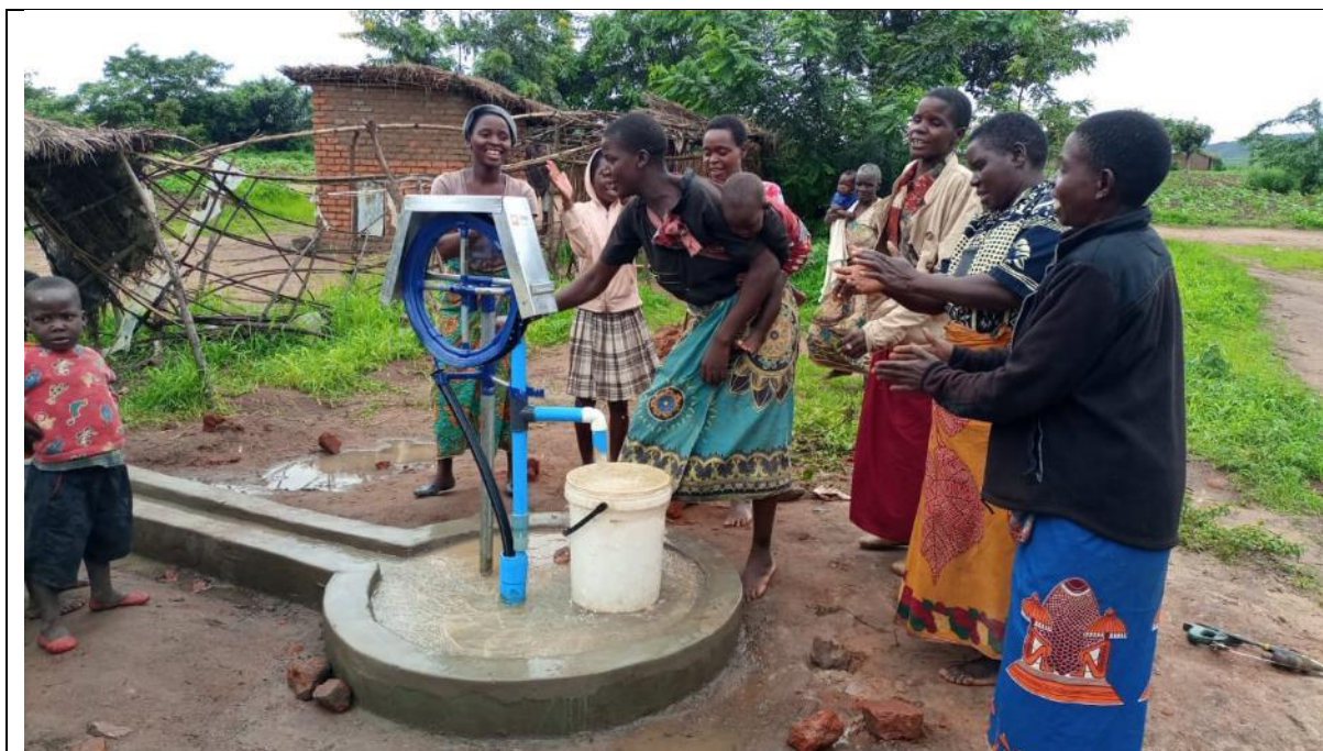
Installatie van touwpomp model 4 bij familie Alick Shapato op een put geboord met de Mzuzu boormethode. Deze put geeft water aan ca 65 mensen.
